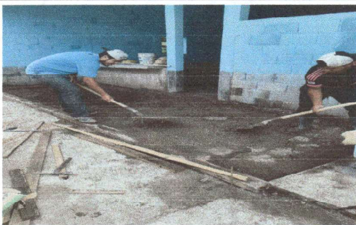
Foto 5: Avances de trabajo en la sustitución de piso para la cocina.
