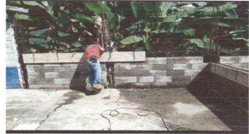
Foto 2: Avances de trabajo en la reparación de muro perimetral de Block con refuerzo columnas y soleras.
