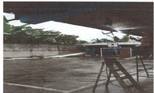
Foto 4: Avances de trabajo en la sustitución de canales y sustitución de soporte de pescante de metal para canales.
