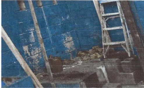
Foto1: Avances de trabajo en la sustitución de las planchas de la cocina.
