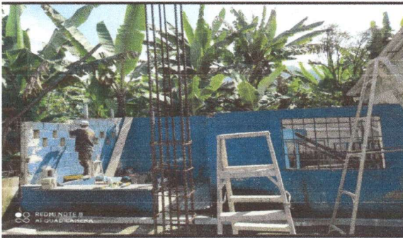
Foto 3: Avances de trabajo en la reparación de la cocina.
